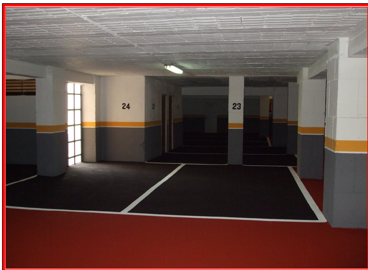
Slurry acrílico. Pavimento resina sintética
