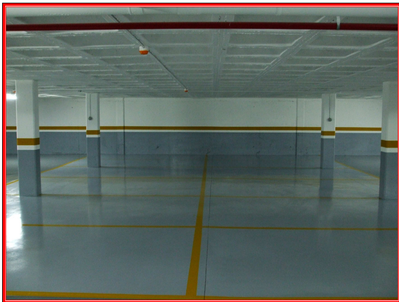
Sistema Epoxi. PAVIPORPOX HYDRO sobre superficie perfectamente preparada.
