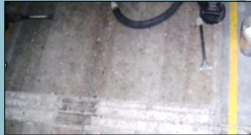
Se profundiza en la junta y se retira el material en mal estado.
