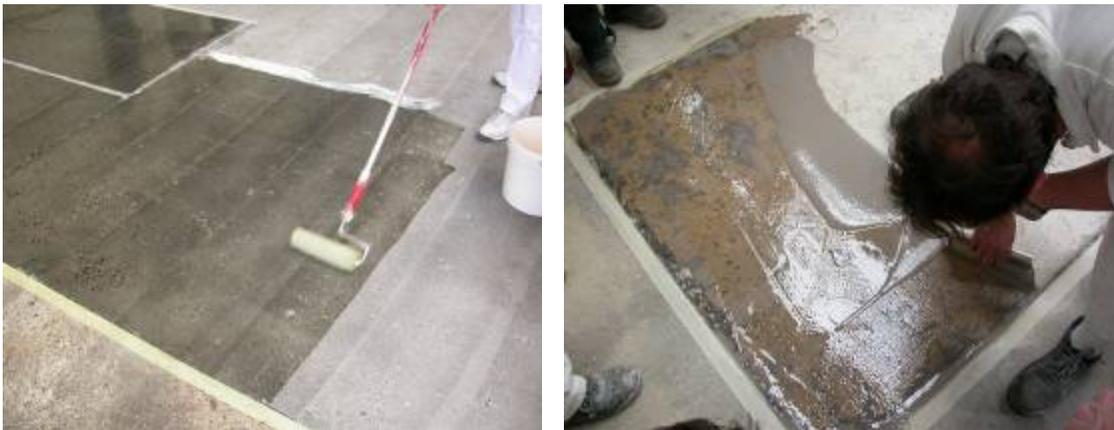
*Aplicación de resina epoxi para formar una barrera contra la humedad*
