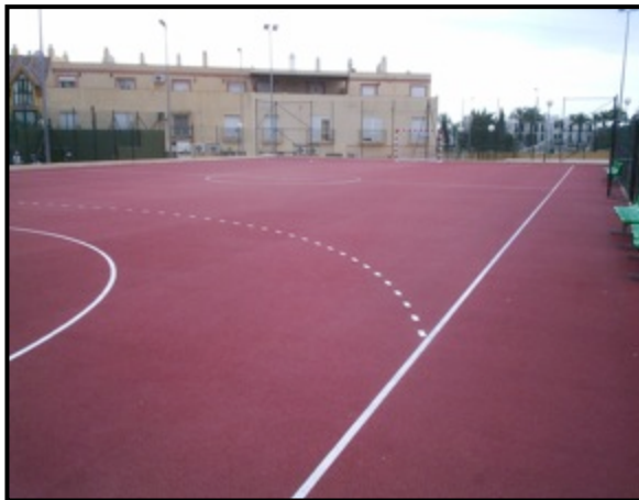
Reparación de pista de pavimento poroso con caucho
